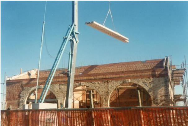
22. Copertura del tetto con travi di legno.
