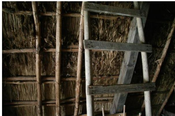
37. *La struttura in legno del tetto di canne.*
