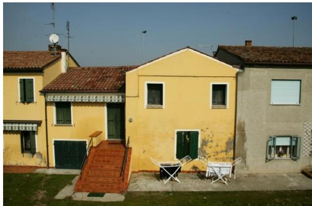
3. La facciata con i segni di umidità e il vistoso filo della corrente elettrica.
