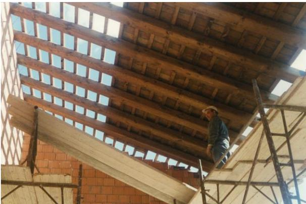
23. Copertura del tetto con travi nuovi e tavelle originali.
