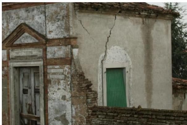
4. La parete destra e i segni del degrado: la crepa e l'infiltrazione d'acqua.
