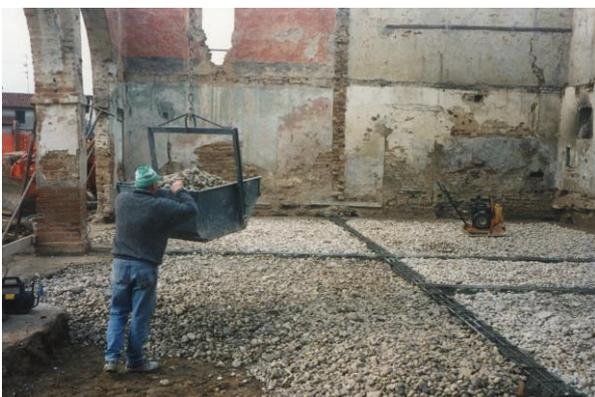
17. Preparazione del sottopavimento con uno spesso strato isolante di pietrisco.
